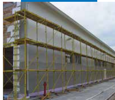
Hőszigetelő táblák simítása: Mapetherm Ragasztótapasz terítése
