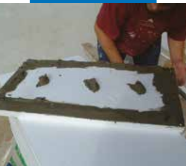
Mapetherm Ragasztótapasz feldolgozása a tábla hátoldalára fogazott simítóval
