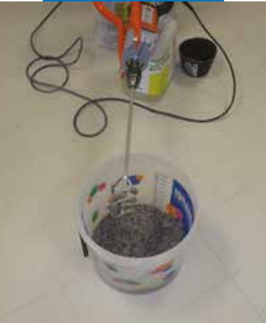
Mapetherm Ragasztótapasz feldolgozása a tábla hátoldalára pontokban vakolókanállal
